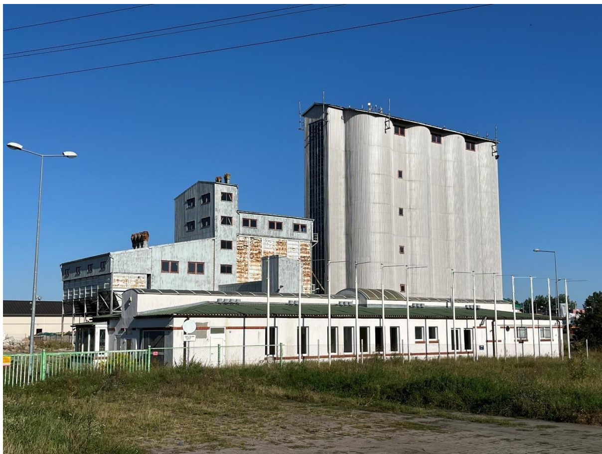
Ryc. 4. Fotografia istniejącego elewatora zbożowego w Przytocznej
